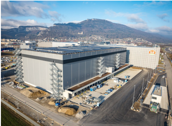
Bild: Referenzprojekt aus dem Anlagenbau Bell Opera Holinden in Oensingen
